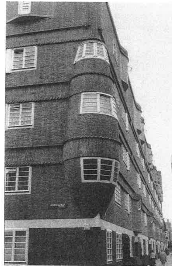
Afbeelding 12. Detail op de hoek van het flatgebouw in de Spaarndammerbuurt in Amsterdam, gebouwd tussen 1917 en 1921 door woningbouwvereniging Eigen Haard (hoek Zaanstraat-Hembrugstraat). De architect is M. de Klerk. Dergelijke ronde uitbouwen zijn een herkenbaar onderdeel van de Amsterdamse School.
