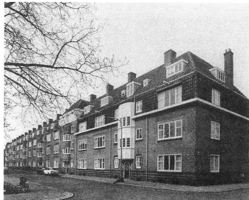
Afbeelding 15. De bordessen tegen de trappenhuizen geven de gevel een bijzonder accent. De bordessen op de hoeken van de complexen zijn in hout uitgevoerd.
