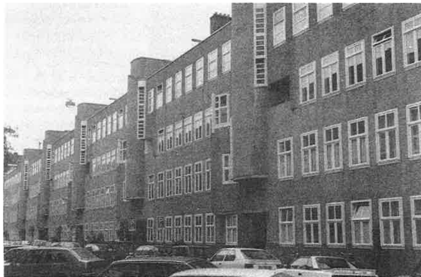
Afbeelding 13. Vergelijkbaar met de flatgebouwen van Het Nieuwe Woonhuis zijn deze flatgebouwen voor Woningbouwvereniging De Samenwerking aan de Bronckhorststraat in Amsterdam, gebouwd in 1922-1923. De architect is J.F. Staal. Hier wordt de ingang van de trappenhuizen benadrukt door een verticale uitbouw aan de gevel.
