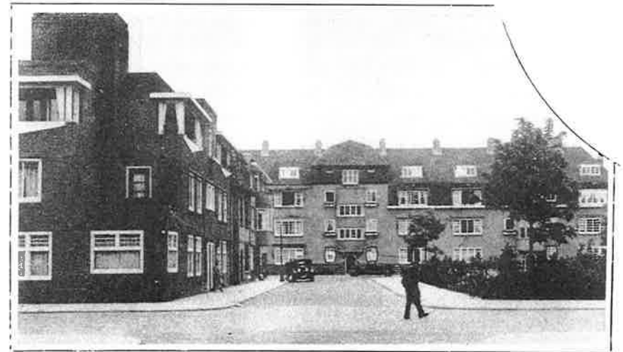
Het Hobbemaplein vormt ook al een zeer modern stukje van onze hoofdstad. Men ziet hier juist op een der ruime flatwoningen, waarvan de voordeur toegang geeft tot zes aparte huizen. Langs de deurposten zijn dan ook zes drukbelletjes en zes naambordjes aangebracht.
